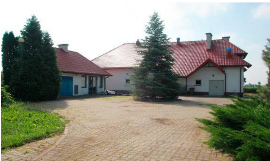
Fot. Oczyszczalnia ścieków w Opinogórze Górnej w 2021 r. po rozbudowie.
